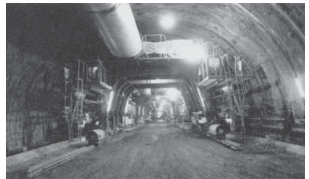
（仮称）新紀見トンネル トンネル内
